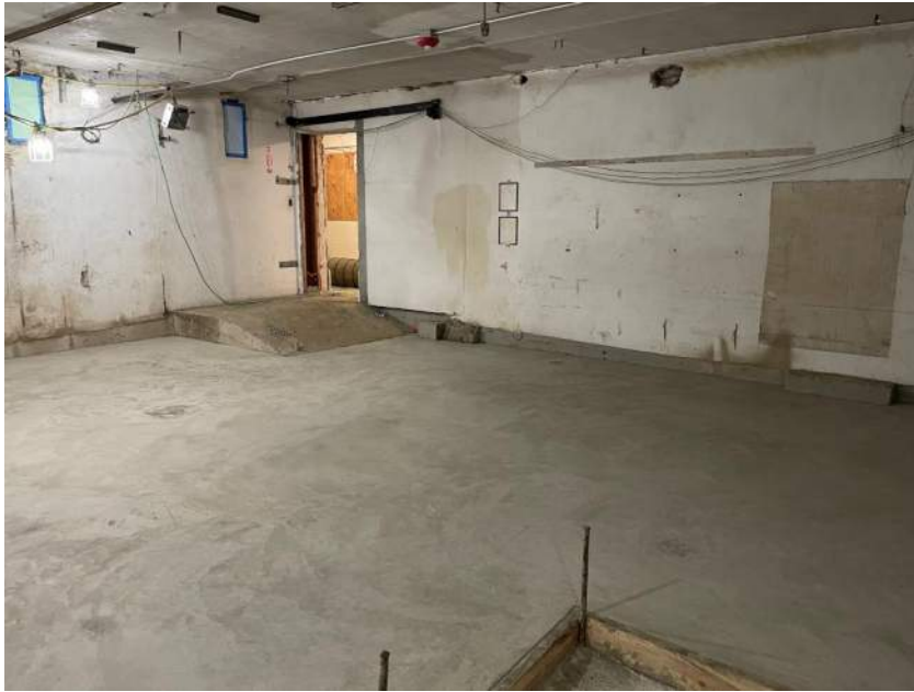
CHHS – Boiler room slab pour back
