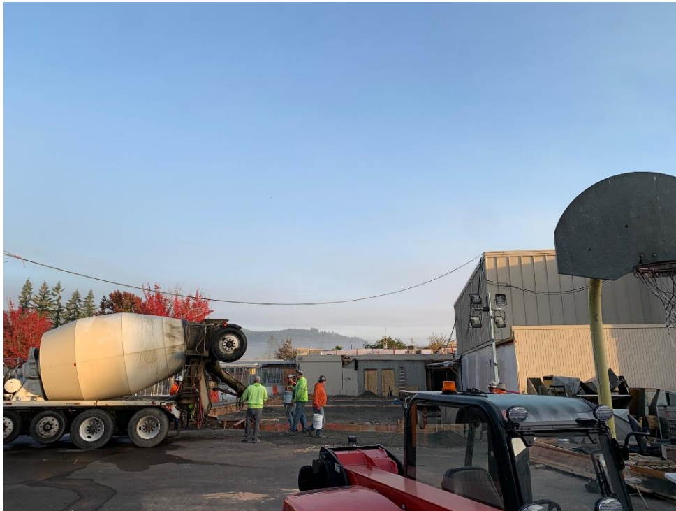
Stem Wall Concrete Pour at Science/Art Wing
