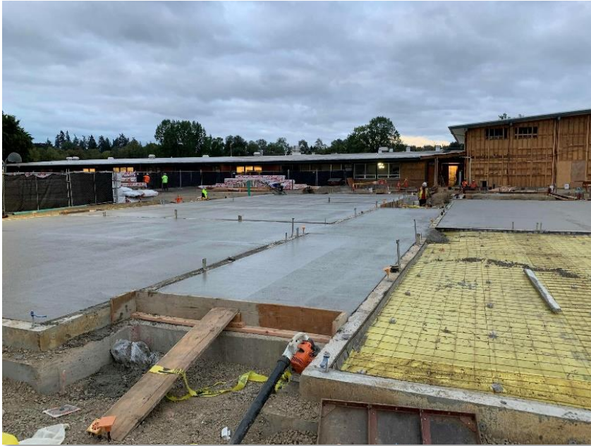
New Addition Slab Pour
