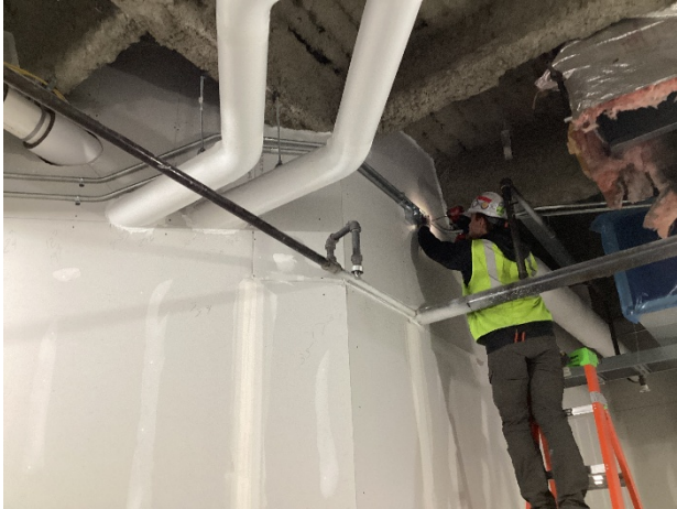
Drywall Taping
