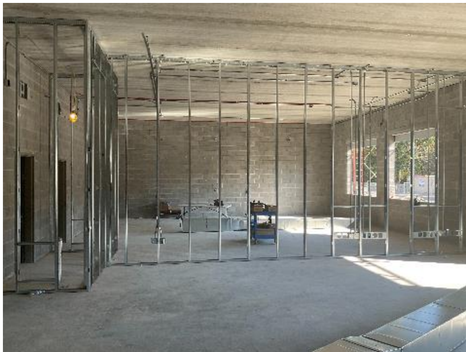
Metal Stud Walls
