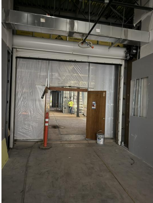
AREA 4 – FIRE DOOR
