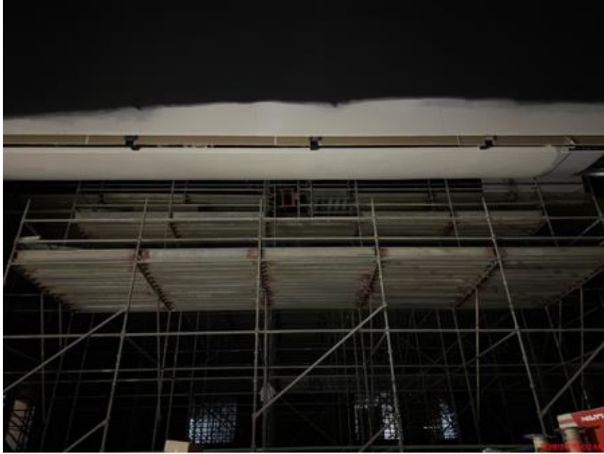
Drywall over the Proscenium
