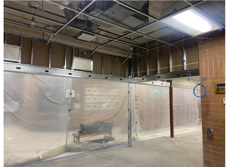
Metal stud framing above future storefront
