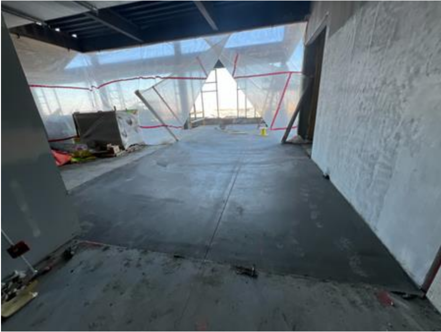
Concrete pour backs in the vestibule area
