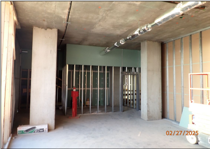
14 1st Fl., East tenant spaces, Slabs poured
