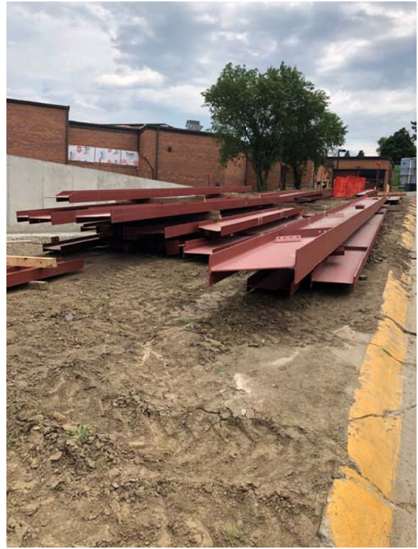
Commons structural steel stocked
