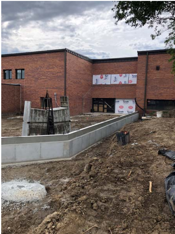
Commons foundations walls
