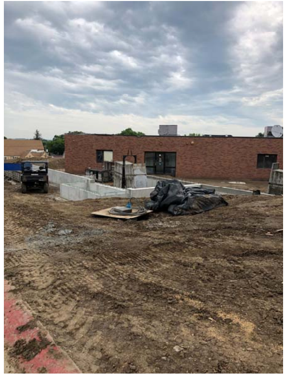
Commons foundations walls
