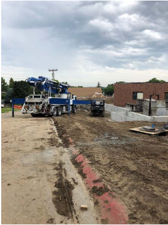
Commons foundations walls
