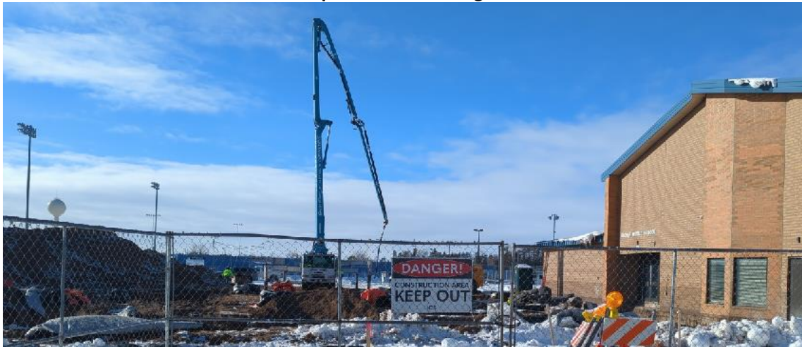
Pump Truck for Footing Pour
