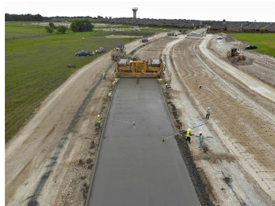
Concrete Pour at Kinship Parkway
